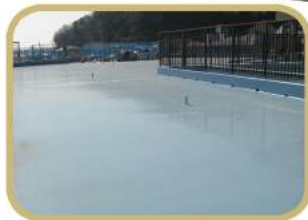
防水施工中の屋上
