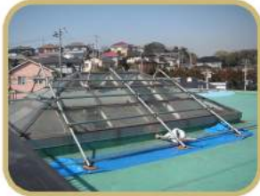
天窓防水シールの取替え
